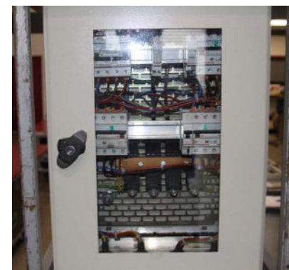
Armoire électrique 125A – 4x32A
