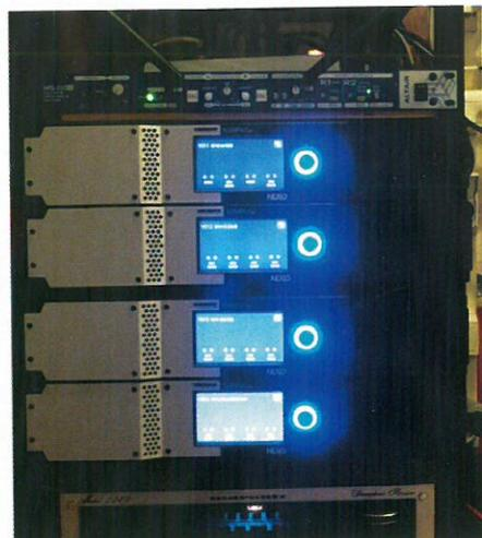
Les amplificateurs Nexo NXAMP4x2 mk2 sont installés dans un rack en coulisse. Ils assurent le processing de calage de l'ensemble du système.
